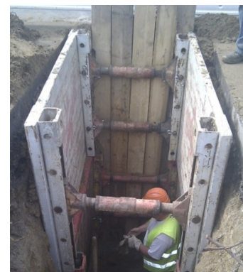
Baugrube mit Verbau
