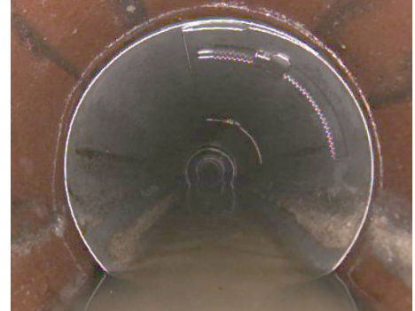
eingebaute Innenmanschette in einem Schmutzwasserrohr
