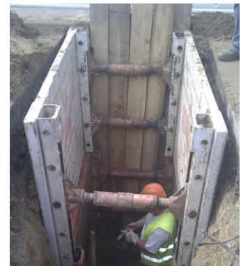
Baugrube mit Verbau
